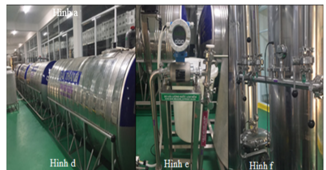
Hình 4. Bố trí và lắp đặt các thiết bị hệ làm mềm. (a - Bơm nước nguồn, b - Các cột lọc thô, khử mùi, làm mềm, c - Cột lọc tinh, bồn chứa muối, d - Bồn chứa nước mềm, e - Thiết bị đo lưu lượng, f - Thiết bị cảm biến áp suất)
