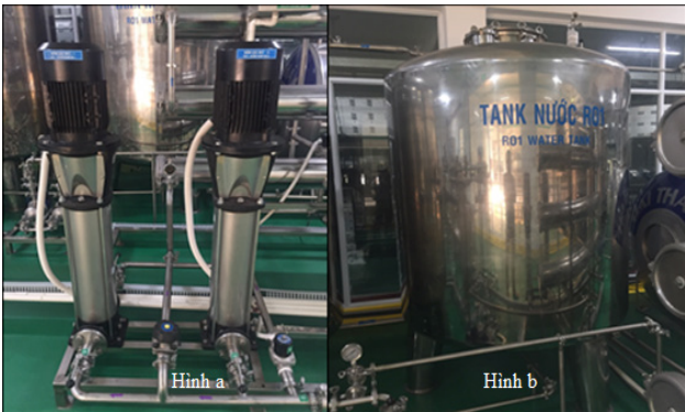
Hình 5. Bố trí lắp đặt các thiết bị hệ RO1. (a: Bơm trực đứng đa tầng áp cao b - Bồn chứa nước RO1, c - Các van màng, các cảm biến độ PH và độ dẫn điện, d - Các cột lọc RO)
