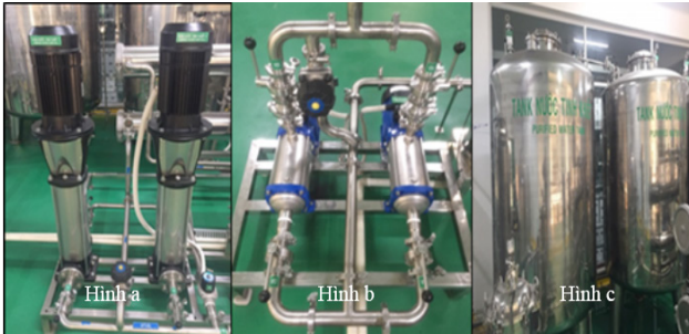
Hình 6. Bố trí và lắp đặt các thiết bị hệ xử lý nước tinh khiết. (a - Bơm trực đứng đa tầng áp cao, b – Bơm tuần hoàn nước tinh khiết, c – bồn chứa nước tinh khiết, d – Thiết bị khử khoáng EDI, e- thiết bị đo lưu lượng, thiết bị tiệt trùng tia UV, f- các cảm biến độ dẫn điện, PH online)
