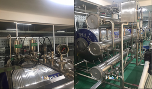
Hình 5. Bố trí lắp đặt các thiết bị hệ RO1. (a: Bơm trực đứng đa tầng áp cao b - Bồn chứa nước RO1, c - Các van màng, các cảm biến độ PH và độ dẫn điện, d - Các cột lọc RO)
