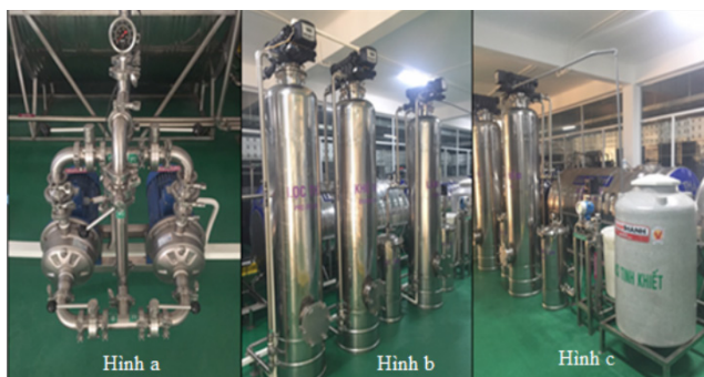
Hình 4. Bố trí và lắp đặt các thiết bị hệ làm mềm. (a - Bơm nước nguồn, b - Các cột lọc thô, khử mùi, làm mềm, c - Cột lọc tinh, bồn chứa muối, d - Bồn chứa nước mềm, e - Thiết bị đo lưu lượng, f - Thiết bị cảm biến áp suất)
