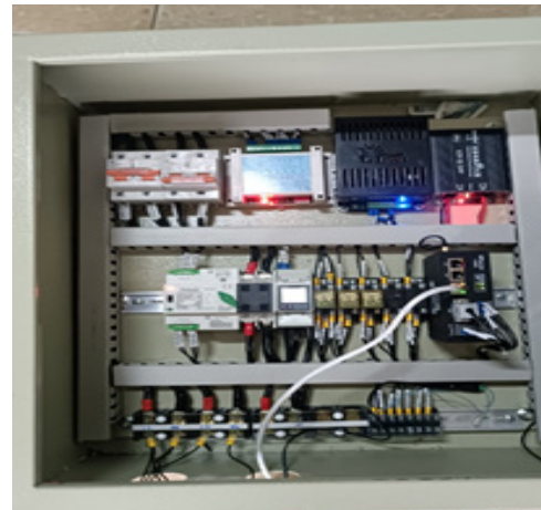
Hình 2.4. Chế tạo lắp ráp phần cứng cho mô hình thực hành IoT trên tủ ATS.
